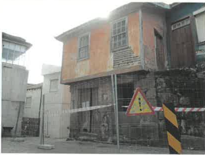
Travessa da Parteira – vedação aplicada
