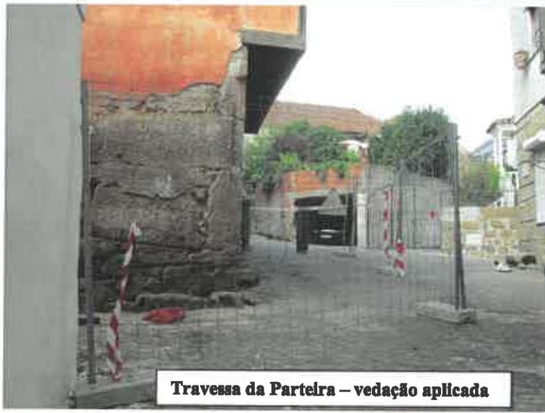
Travessa da Parteira – vedação aplicada
