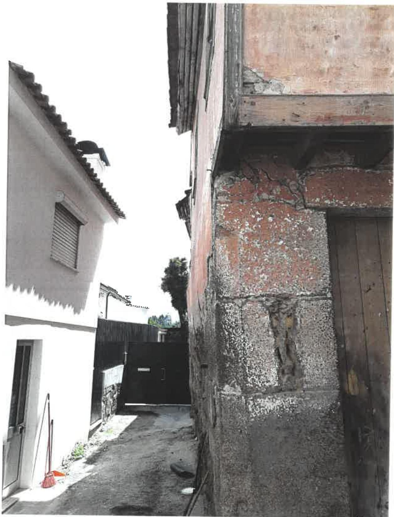
*Fotografia 2 - Visto do edifício com a pronunciada barriga para a Travessa da Parteira e evidente fissuração.*
