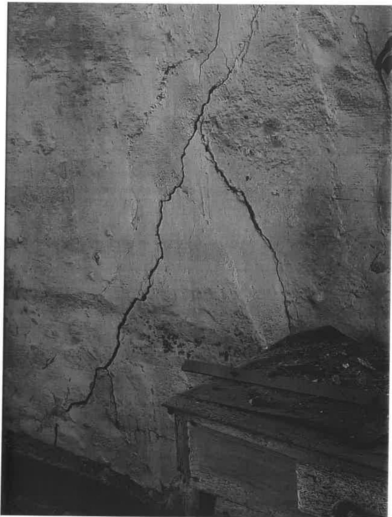
*Fotografia 6, vista de fissura em parede no interior perpendicular à Parede da Travessa da Parteira.*
