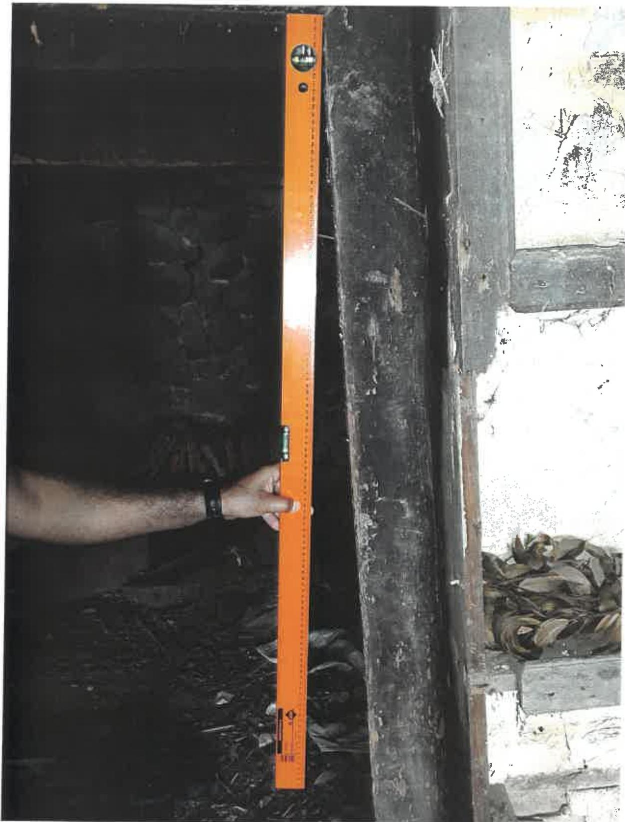
*Fotografia 3, vista com a evidente inclinação dos elementos do edifício*
