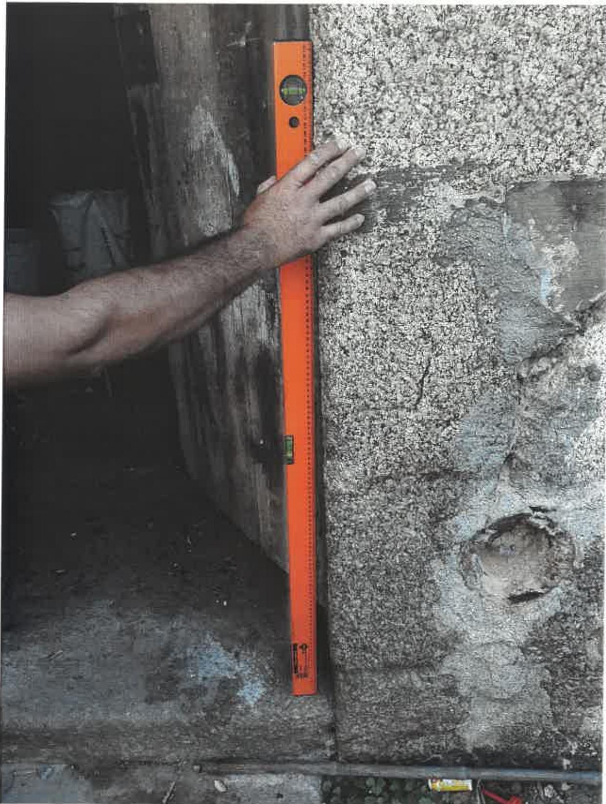
*Fotografia 4, vista com a evidente inclinação do edifício.*
