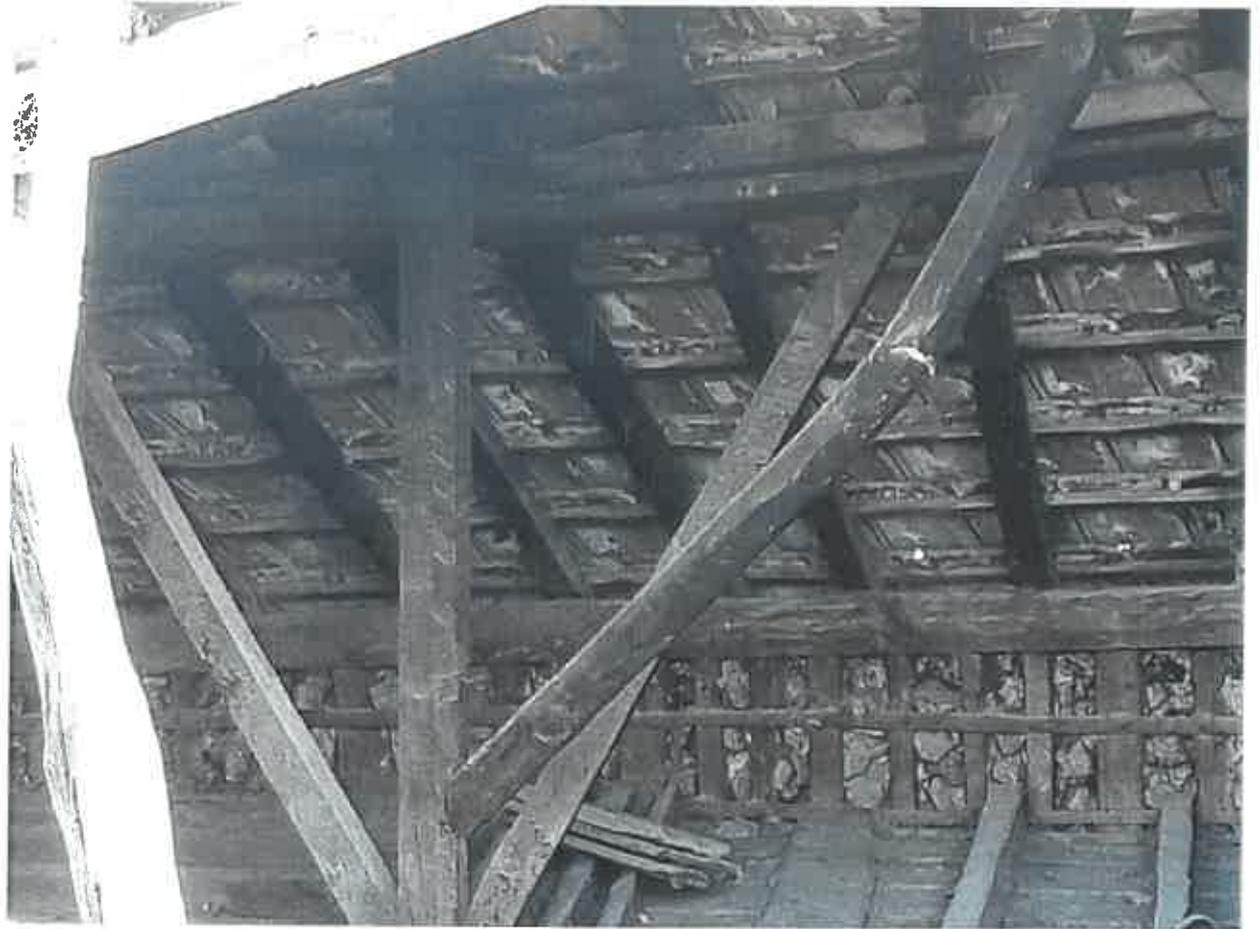
*Fotografia 9 - Vista de elementos estruturais da cobertura do edifício azul com rotura*
