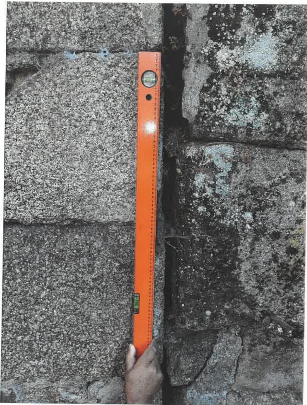
*Fotografia 5, vista com a evidente inclinação do edifício e descolamento do contíguo.*
